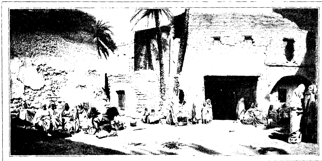
LE SOUK. AU FOND, PORTE DU QUARTIER DE DERAR.
